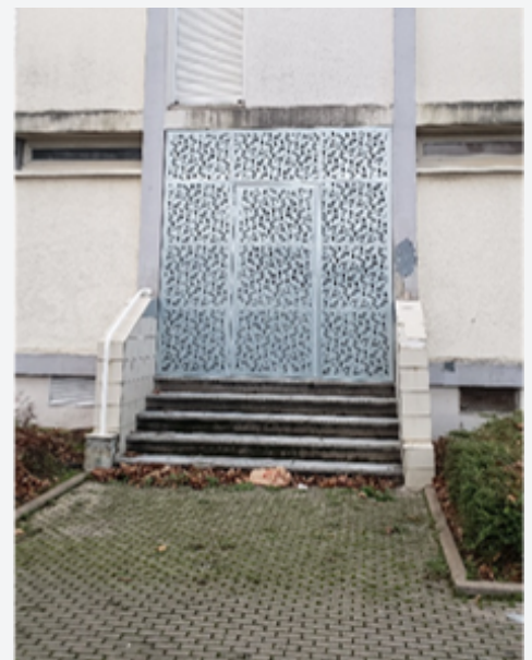
photographie 1 : Exemple d'un des halls fermés
