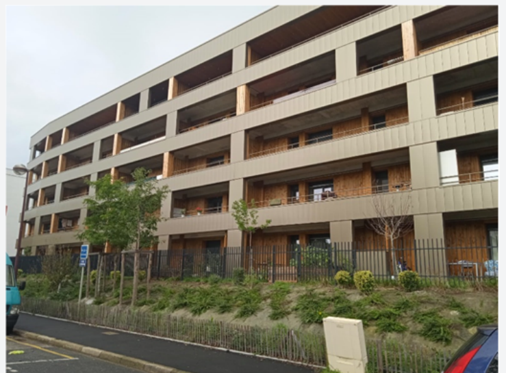
photographie 2 : Vue sur la résidence réhabilitée (isolation thermique, création de loggias et de jardins en rez-de-chaussée)
