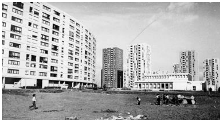
Image 1 : Le tout récent quartier de Malakoff à Nantes en 1972 avec les formes caractéristiques des grands ensembles. Archives municipales de Nantes
