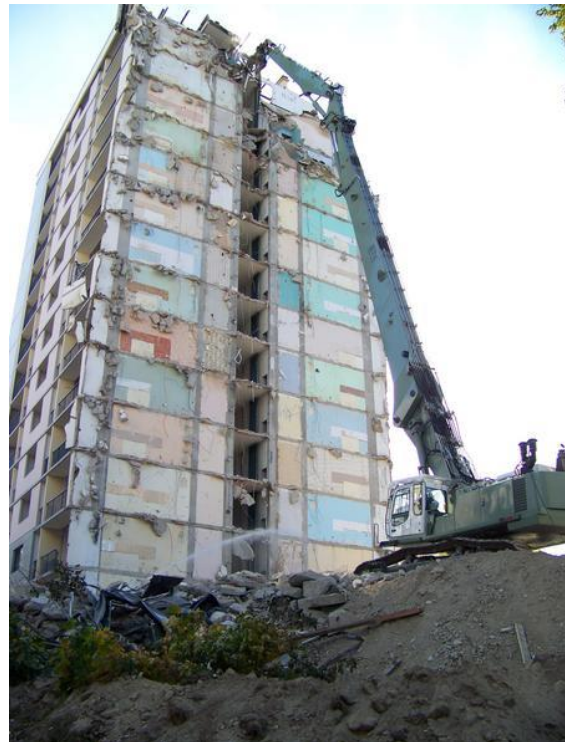
Image 4 : Démolition de la tour Guergadi, 2007. Kervénanec, Lorient.
