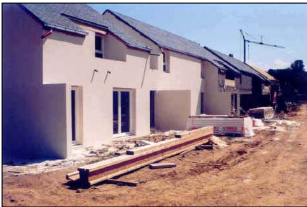
Chantier de Rosalic
