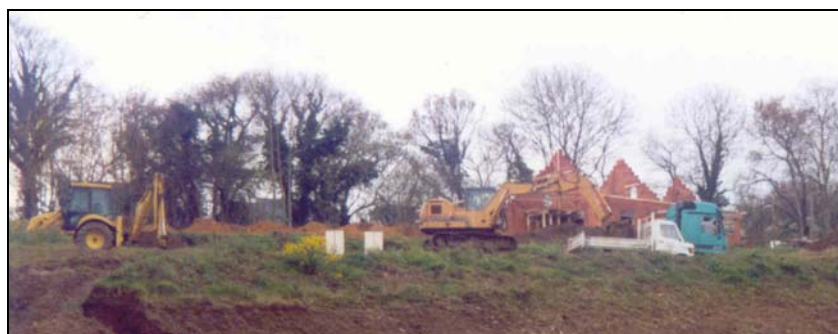
Chantier de Kerlitos
