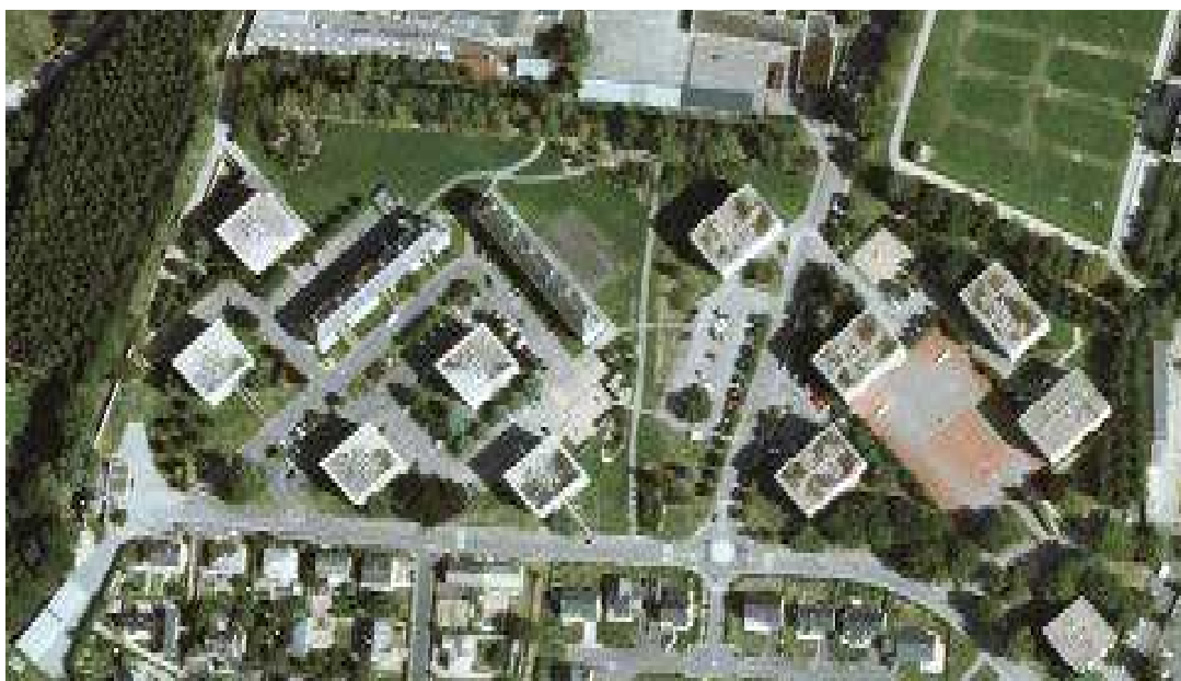
Source : Services Techniques Ville de Vitré, photographie aérienne - Quartier Maison Rouge.
